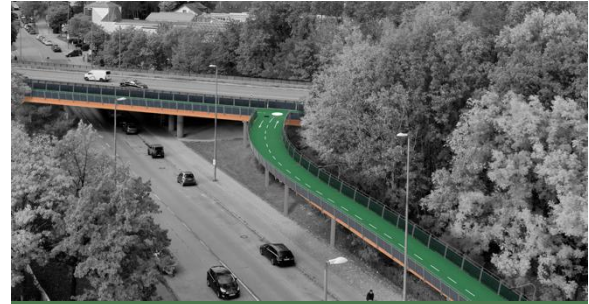
Entlang von Böschungen
